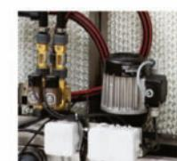
Поддон и направляющие изготовлены из коррозиестойких материалов. Трубопроводы выполнены из высококачественного пластика. Материал испарительных пластин характеризуется высокой прочностью и долговечностью.
