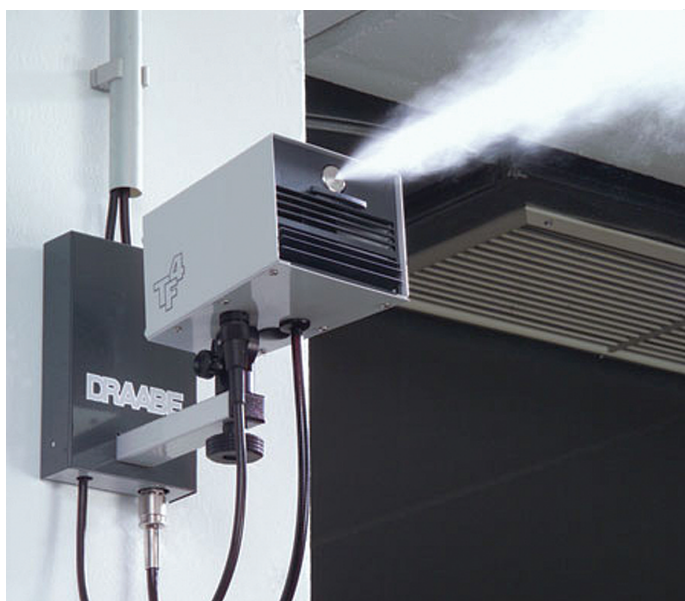
TF 4 и TF 8.1 Атомайзер с одной или двумя форсунками производительностью 4 кг/ч и 8 кг/ч соответственно
